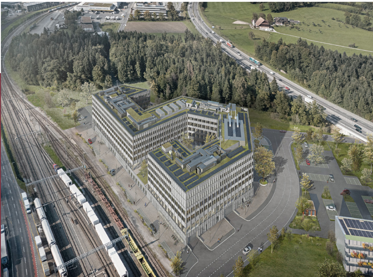
Abbildung 14: Das Sicherheitszentrum Rothenburg soll ab 2032 auch die Dienststelle Lebensmittelkontrolle und Verbraucherschutz beherbergen. © Renderisch GmbH
